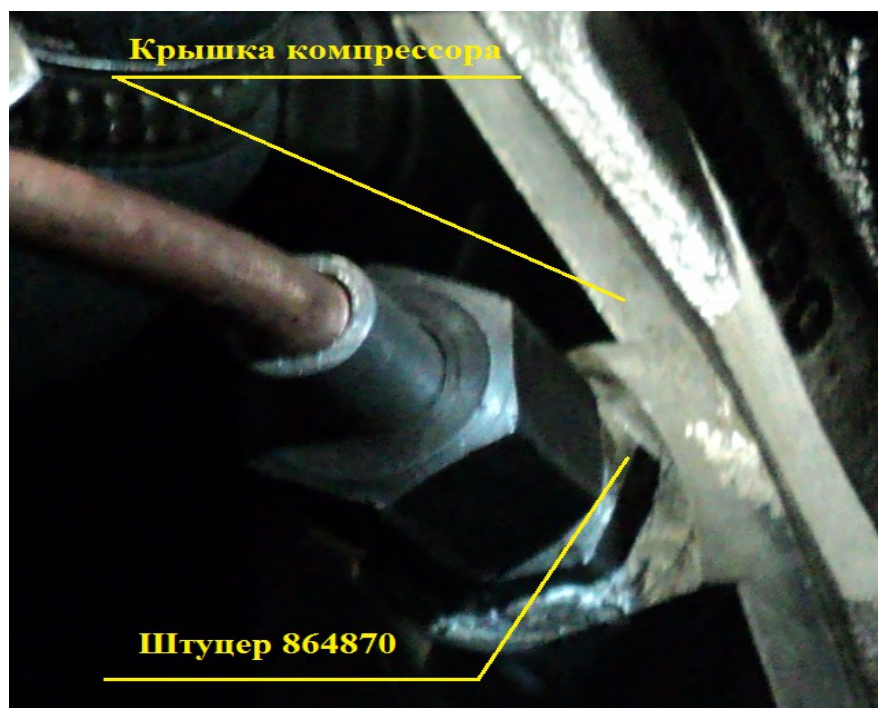
Фото 5. Установка штуцера 864870 в заднюю крышку компрессора.
